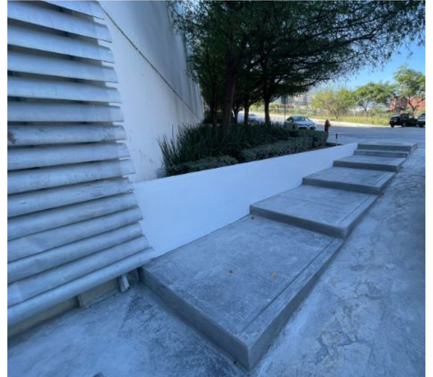
Demolición y reconstrucción de barda exterior E5
