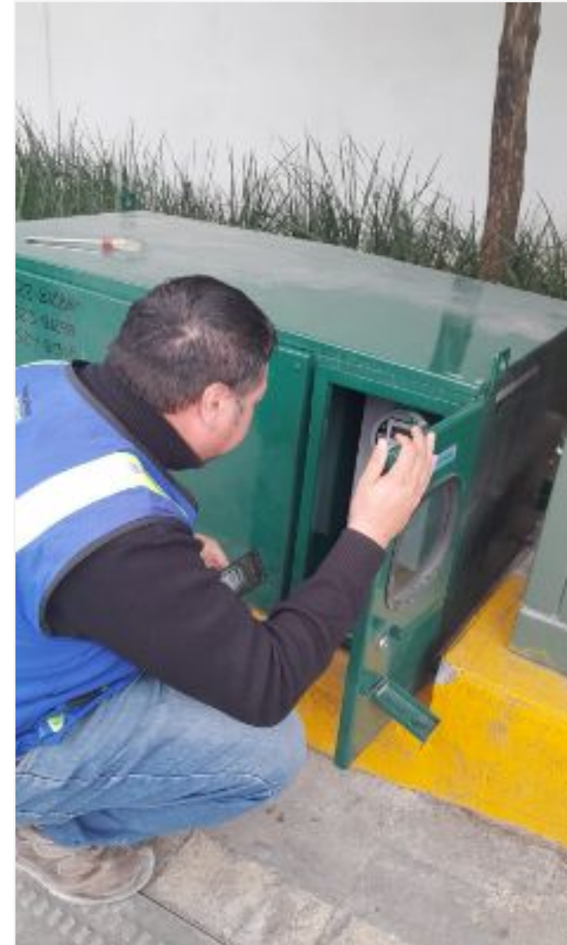
Instalación de TPI nuevo y libranza de CFE
