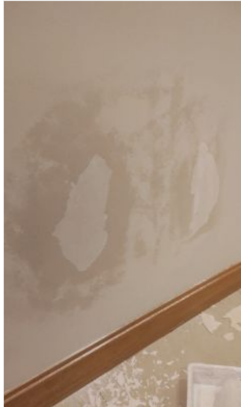
Reparación de muro torre EAST
