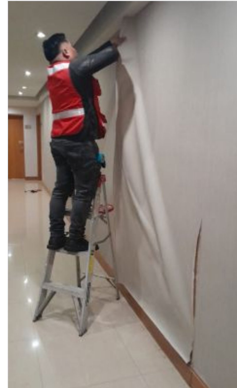
Retiro de tapiz dañado en torre WEST
