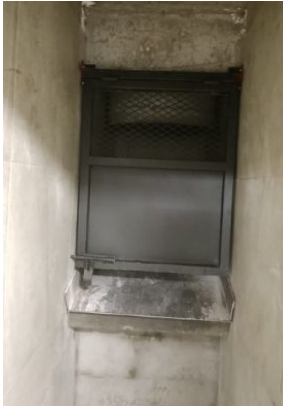
Reparación chute EAST
