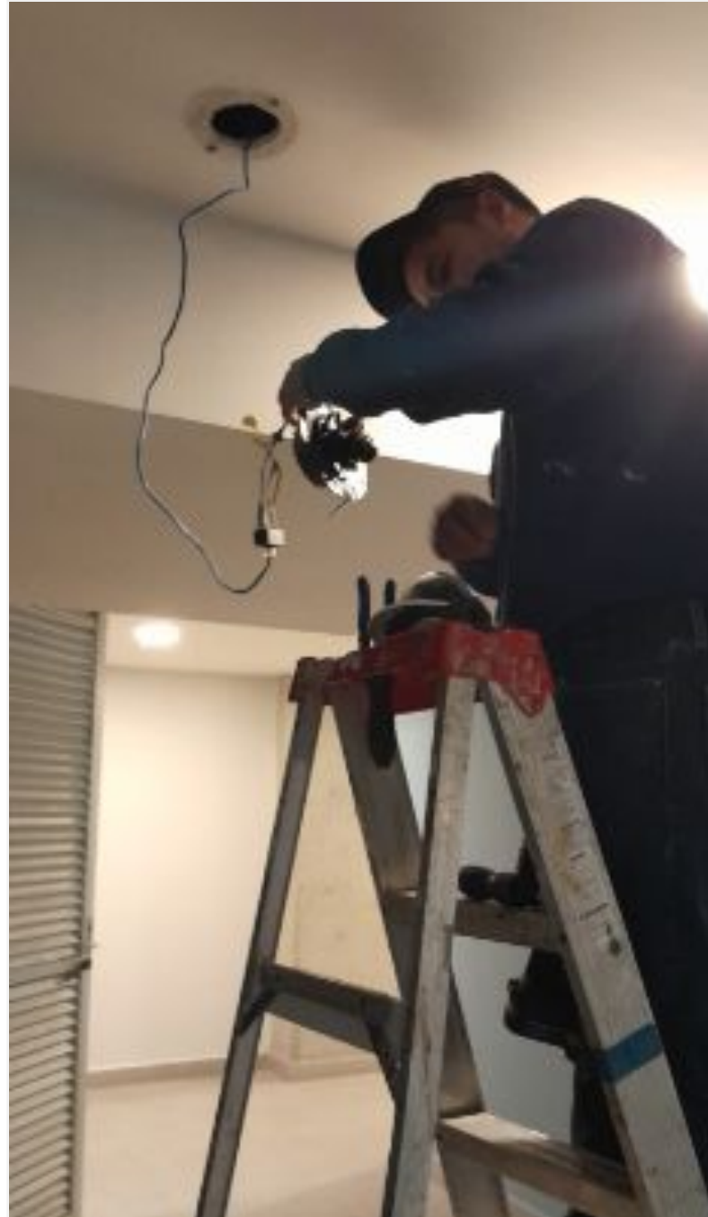
Colocación de cámara
