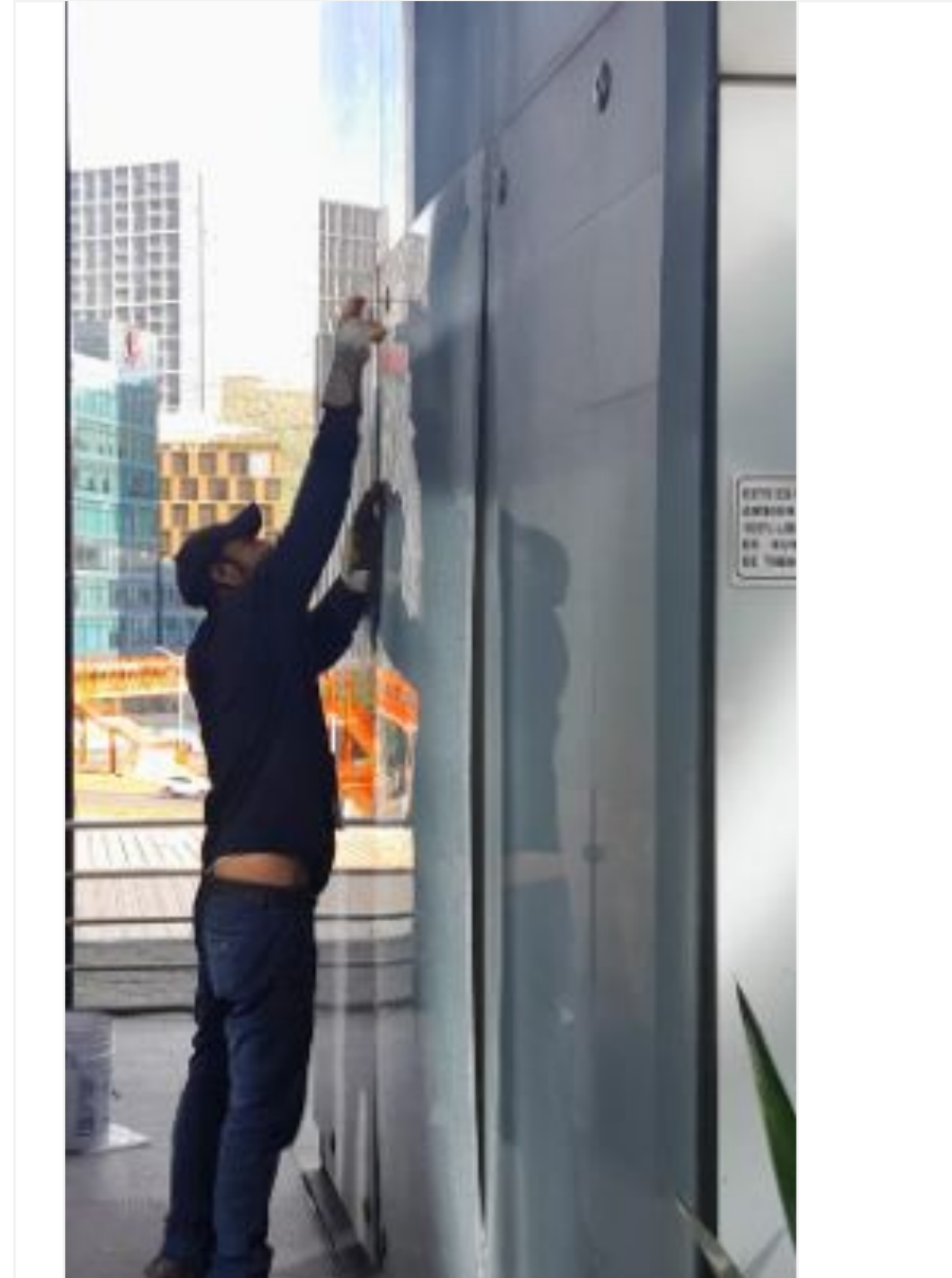
Cambio de cristal dañado
