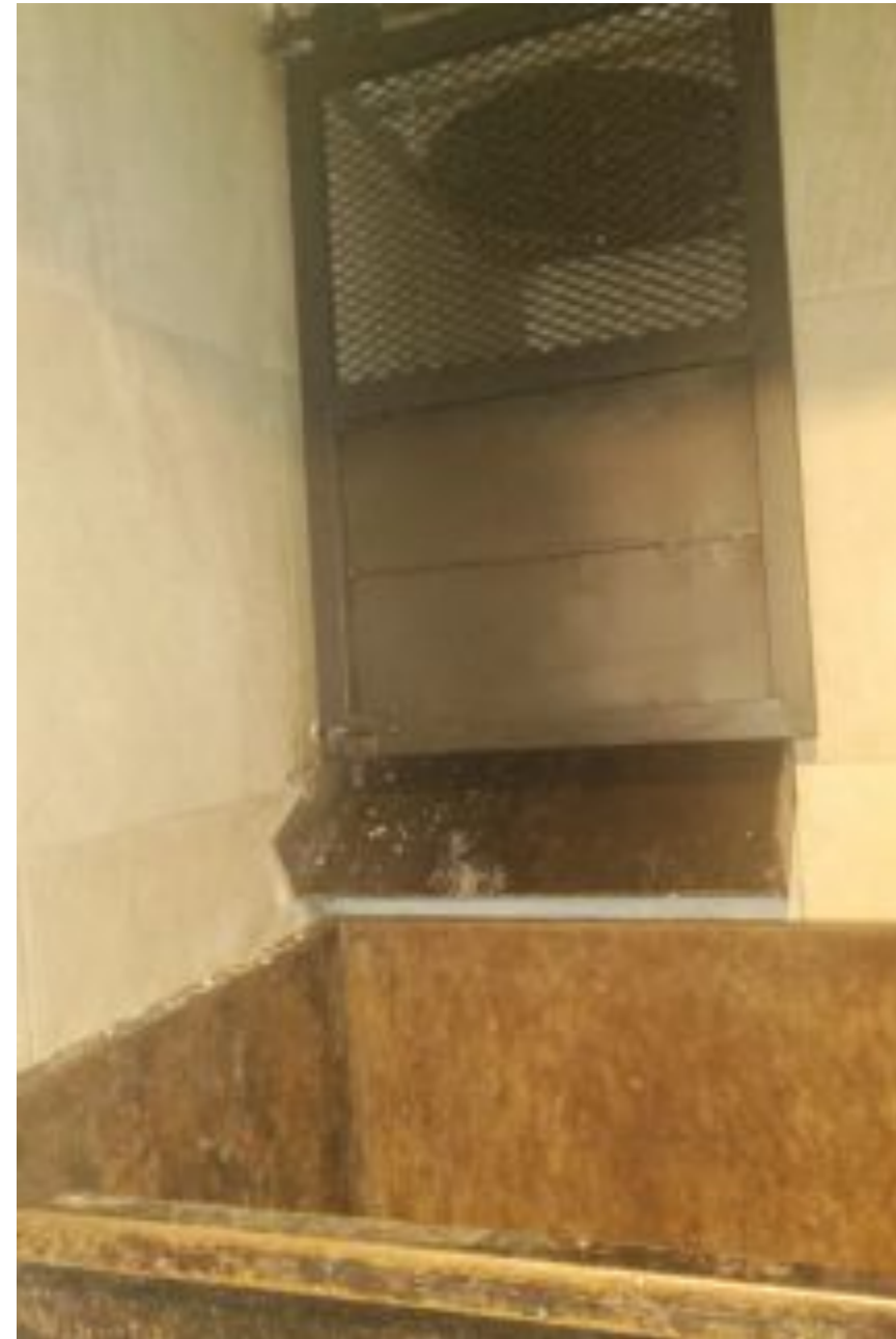
Reparación de chute WEST
