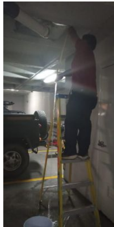
Limpieza de charolas en estacionamientos
