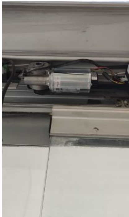
Ajuste de motor a puerta corrediza lobby east
