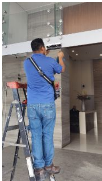
Ajuste de motor a puerta corrediza lobby east
