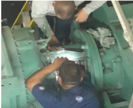
3GH: mantenimiento preventivo a chillers
