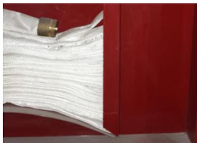
Se realiza la inspección de extintores y cubos de mangueras contra incendio localizado boquillas faltantes y extintores
