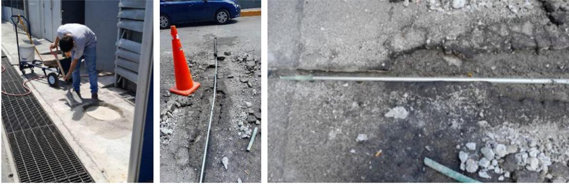
Se realiza la reparación de la tubería de alimentación de las luminarias de la entrada de E5 ya que presentó un corto circuito, se sustituye por tubo rígido
