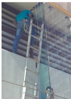
La empresa aluvri se realizó la reparación de una de las costillas que se desprende de su soporte en el área del gimnasio west
