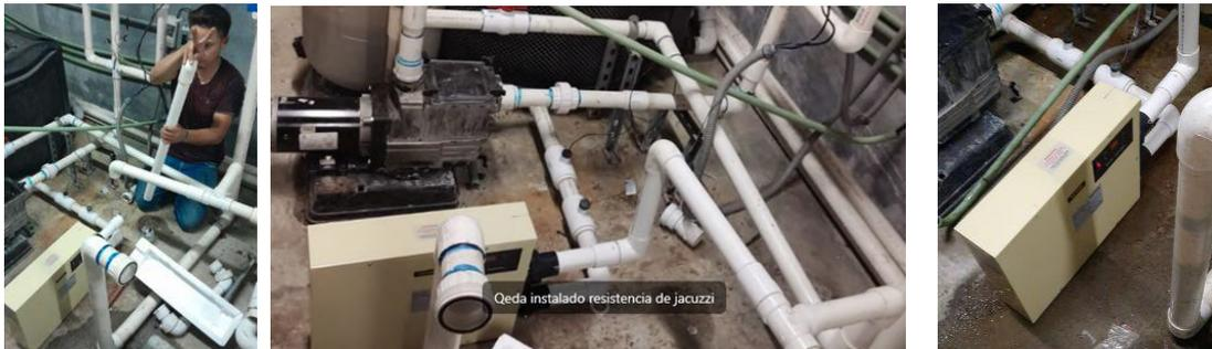
se instala el calentador del hidromasaje, colocando el set point en 35 grados centígrados, probando satisfactoriamente su operación
