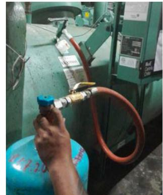
Para realizar las primeras pruebas de arranque, se coloca 140 kilos de gas refrigerante
