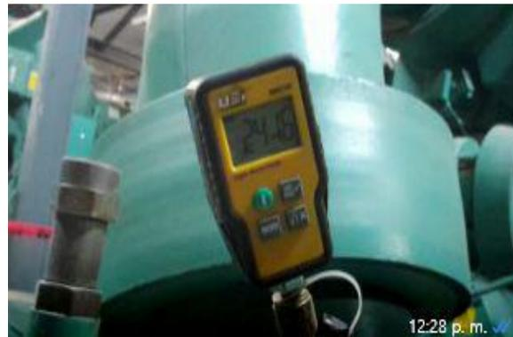
Previo a la instalación del gas se coloca un generador de vacío para confirmar el sello general del sistema
