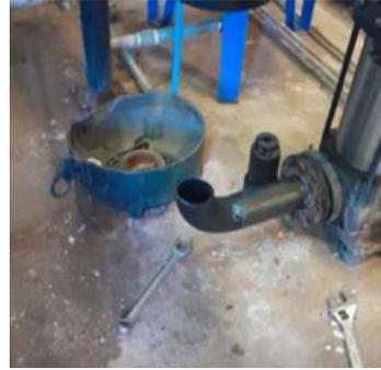
El proveedor IPM de instalaciones hidroneumáticas, colocando tubería nueva en el área de bombas
