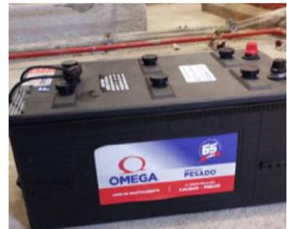
La empresa SISTEQ que da servicio compartido entre Espacia y Torre LIU para la planta diesel contra incendio cambiar las baterías en por caducidad ya que presentó alarma el sistema
