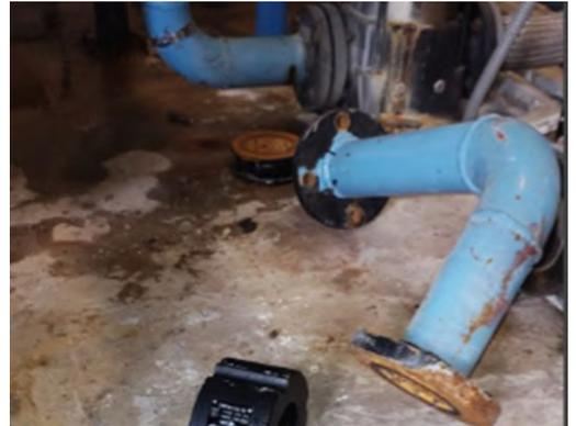
Se recibe a ipm para la colocación de piezas faltantes para el arranque de la bomba #2 de hidroneumático de media presión
