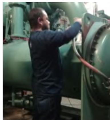
El proveedor 3GH desmonta el sello mecánico del chiller 2
