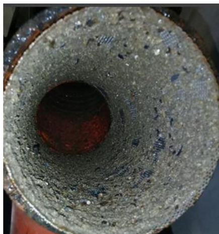
Se cambia sensores de temperatura del chiller 1 y se hace limpieza de cedazo del condensador
