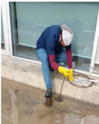
Desazolve de tubería pluvial del área de jardín
