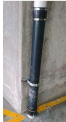
Se hace cortes de tubería pluvial para hacer desazolve de basura en el área de puente en E1, con esto prevenimos fugas en tuberías de area de sotano E1
