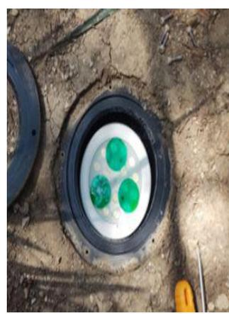
Reposición de alumbrado fundido en las áreas de jardines y edificio
