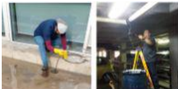
Desagüe y limpieza de coladeras de drenaje pluvial
