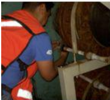
3GH, mantenimiento preventivo de Chillers
