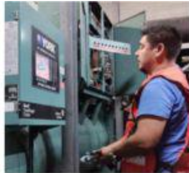
3GH, mantenimiento preventivo de Chillers
