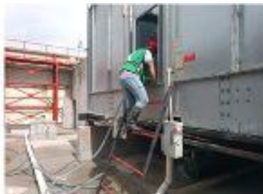
TQI, visita semanal para el análisis químico del agua de la torres de enfriamiento y mantenimiento preventivo a torre 3
