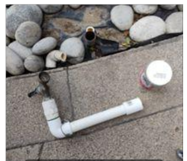
Reparación de daño en tubería de agua
