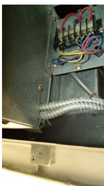
Revisión de caja de conexiones en East para el encendido de calefacción GyM's
