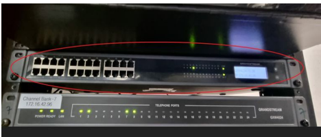
Mantenimiento a conmutador
