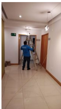
TELMEX colocando la instalación de servicio para D2201
