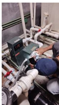
Hidromax revisando las resistencias de calefacción de alberca
