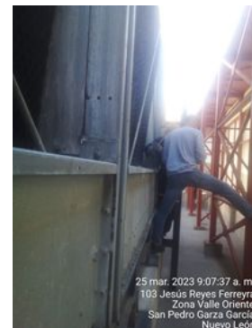
TQI en limpieza de torre #1 de enfriamiento
