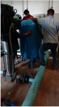
IPM instalando tanque precargado para circuito de alta presión de East
