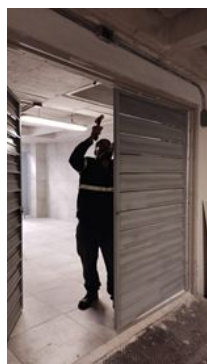
D102 en reparación de la puerta del cuarto de basura
