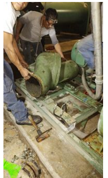
IPM reinstalando la multipropósitos de la B15
