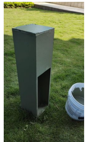
Pintura de luminarias
