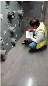
Toma de lecturas CFE
