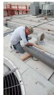
IPM instalando válvulas de las torres 1 y 2 para habilitar el 2do circuito
