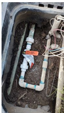
Reparación de goteras en el área de jardín West
