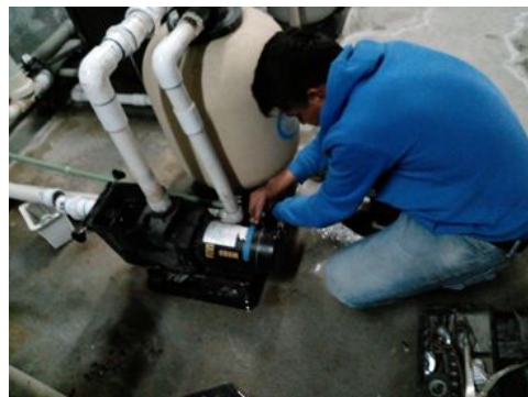
Hidromax reparando fuga en bomba del chapoteadero
