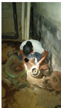
IPM en revisión de la B6 de agua helada para reparación
