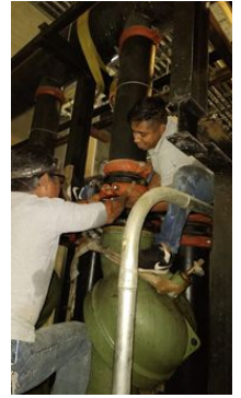
IPM reinstalando la multipropósitos del circuito de condensador B14
