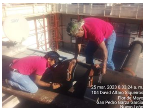
IPM reconectando alimentación de flujo de agua a T1 y T2
