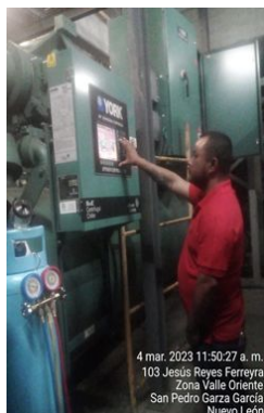
3GH recargando refrigerante faltante posterior a cambi de mirilla
