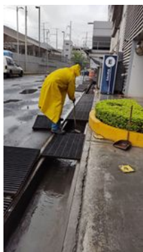
Limpieza de alcantarillado por lluvias y evitar inundación
