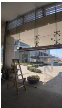
Mantenimiento de puertas de acceso loby East
