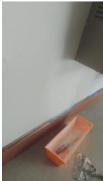
Resane de muros en área de sanitarios west
