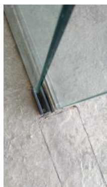
Ajuste de guías para funcionamiento de puertas de loby East
