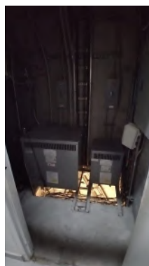
Limpieza de cubos eléctricos de torre East
