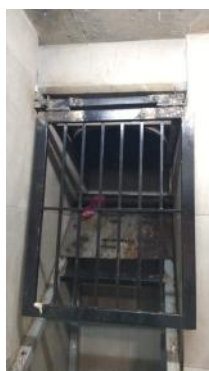
Instalación de reja para evitar golpe de basura.
