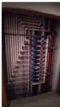
Limpieza de área de válvulas de acceso a medidores de agua
