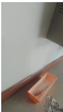
Resanando muros en torre west para pintura de estos.
