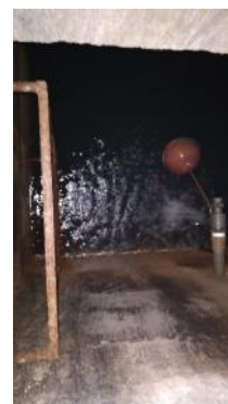
Revisión de mantenimiento y llenado de cisternas de Liu.
