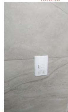
Instalación de interruptor para iluminación de cuatro de basura
