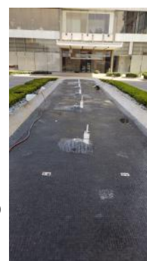
Remozamiento de veneciano de la fuente para su funcionamiento
