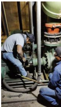
Remozamiento de brida de bomba 14 con soldadura por IPM
