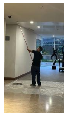
Pintura en área de pasillo central de torre West
