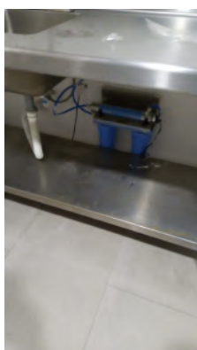
Cambio de filtros del bebedero área de alberca
