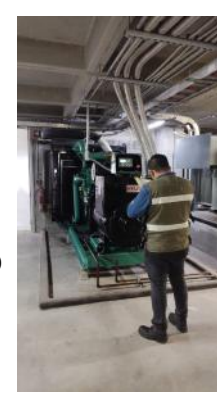
Personal de ISTESA realizando mantenimiento preventivo
