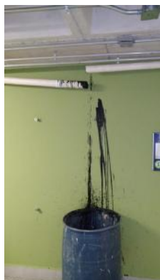
Reparación de drenaje de cuarto de basura E5 East
