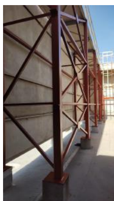
Avance de pintura de la estructura en azotea de west
