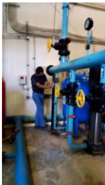
IPM realizando pruebas a tanque precargado
