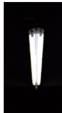
Reemplazo de iluminación que no funcionaba E2-20
