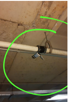
Destapando cañería de E5 para el shut de basura en West
