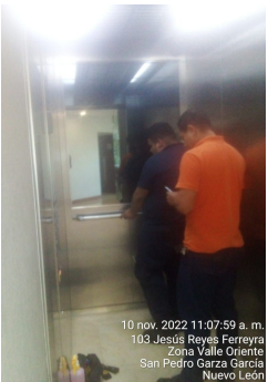
Mitsubishi instalando pasamanos que se cayó.
