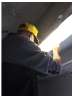
Mantenimiento en reposición de luminarias
