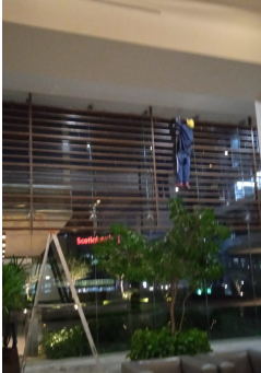
Limpeza de estructura en Loby West
