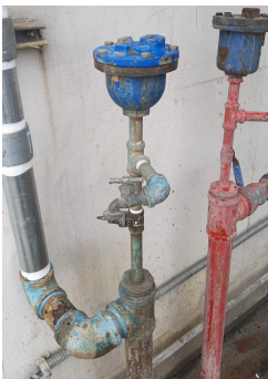
Se repara fuga de agua en azotea de East
