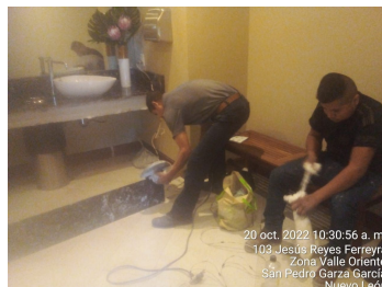
Reparación y colocación faldón de lavamanos en baños de Loby West
