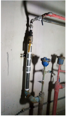
Reparación de fuga en azotea de la torre East
