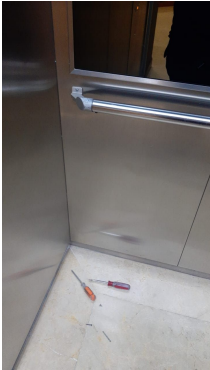
Reparación del pasamanos del elevador de carga de west.
