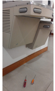
Reparación de bebederos de área de alberca
