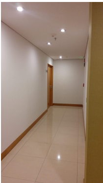
Cambio de focos dañados en pasillos
