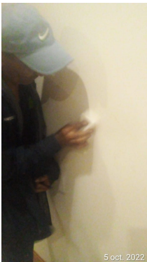
Reparación y pintura de pasillos en East
