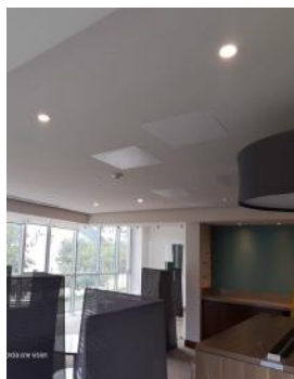
Estandarización de iluminación del centro de negocios
