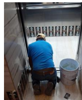
Se inicia con el pulido de los pisos de elevadores.
