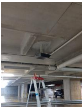
Instalación de charola para contención de gotera
