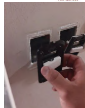
Reparación de interruptor del salon de usos múltiples
