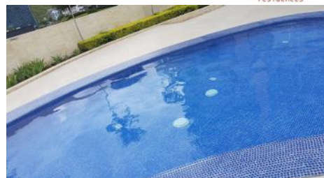
Limpieza y adición de químicos de chapoteadero
