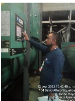
Personal de 3GH en mantenimiento mensual a chiller's
