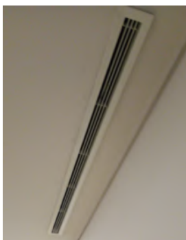
Limpieza y pintura de rejillas de climas
