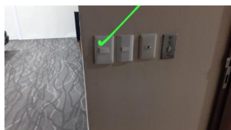
Reparación de contacto en sala de cine
