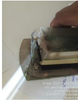
Reparación de botonera de elevador de East
