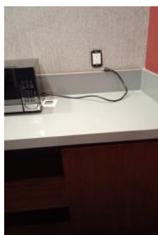
Reparación de contacto eléctrico de área de cine.
