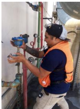
Reparación de fugas de azotea torre East.
