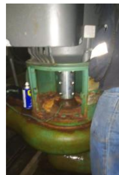
Instalación de la bomba de agua fría por Fimser
