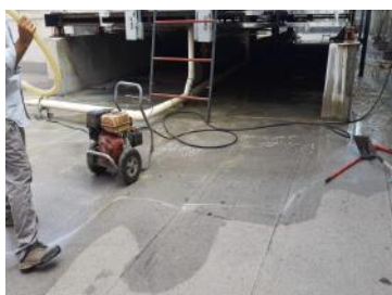
TQI realizando limpieza en las torres de enfriamiento
