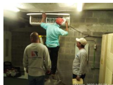
REYNO climas dando el mantenimiento minisplit
