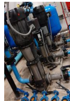
Cambio de válvulas mariposa por Ingeniería Hidroneumática
