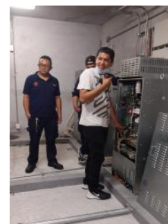
Personal de Mitsubishi para el recorte de cables de elevador #2
