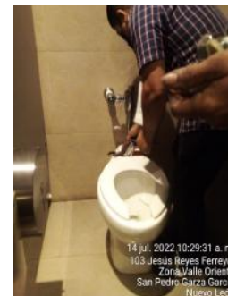
Reparación de fluxómetros del área de alberca y loby West
