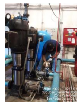
Mantenimiento mensual de hidroneumáticos variadores y bombas
