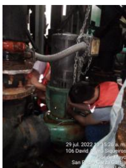
Instalación de bomba secundaria #3 después de su mantenimiento.
