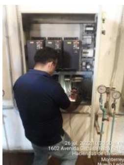
Mantenimiento mensual de hidroneumáticos variadores y bombas
