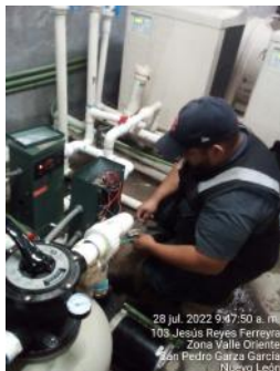
Reparación de sensores de flujo del jacuzzi
