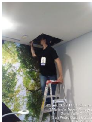
Termo Control en revisión de sistemas de enfriamiento de áreas comunes.
