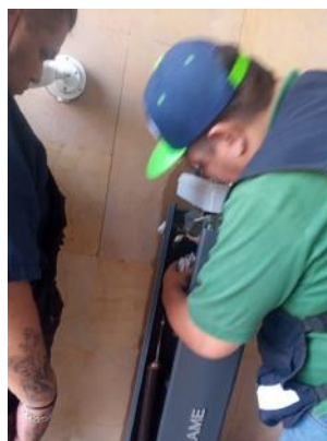
Acercom reparando la pluma de E1 por falla en su funcionamiento.
