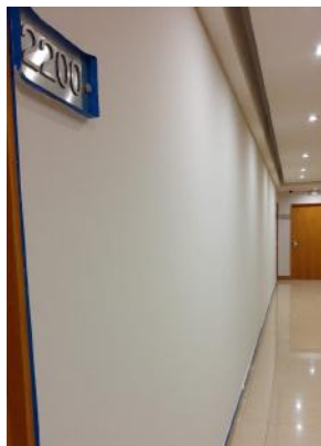
Se inicia pintura de pasillos en Torre East.
