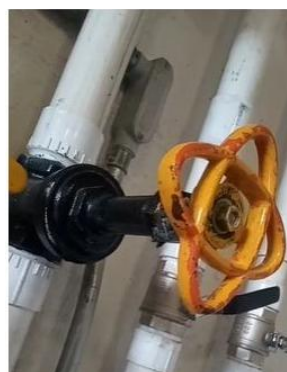
Reparación de fuga en la válvula de 2" del manantial.
