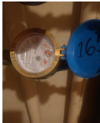
Apertura y cierre de servicios de agua potable.
