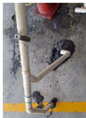
Se destapa cañería de sanitarios de hombres en E1.
