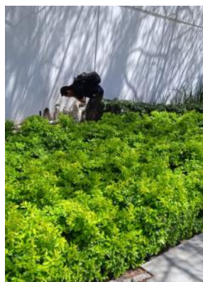
Reparación de fuga en jardines ubicados en Jesús Reyes.
