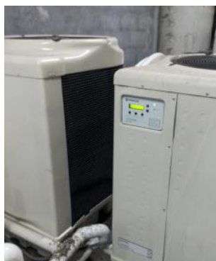
Mantenimiento de calefactores para la alberca.
