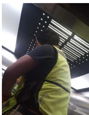
Reparación de la iluminación de los elevadores de East y West.
