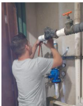
Reparación de fuga en válvulas de Lobby West.
