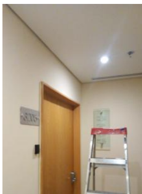
Reparación de la iluminación de pasillos Torre East.
