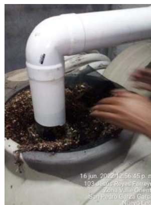
Limpeza del sistema de separación de sólidos del área de albercas.
