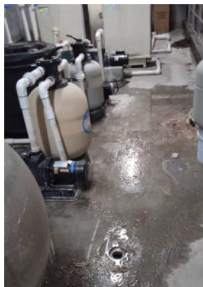
Se realiza cambio de filtro que abastece el chapoteadero.
