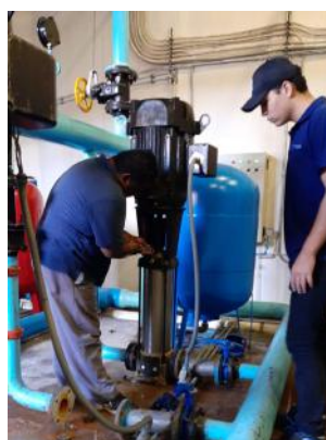
Ingeniería Hidroneumática reparando Bomba 1 de alta presión sello mecánico
