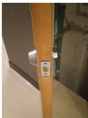
Instalación de cerradura en piso 26 por daño y mal funcionamiento.
