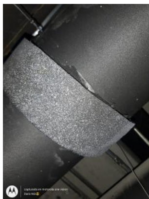
Remozamiento del aislamiento de las tuberías de agua helada.
