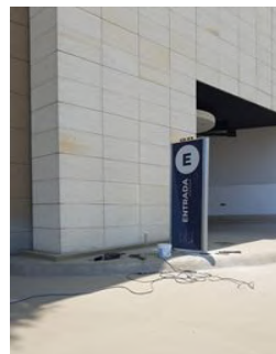
Colocación de totem en acceso E1.
