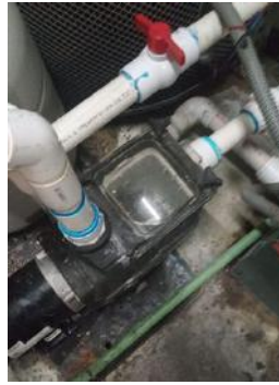
Reparación de empaque de bomba de chapoteadero.
