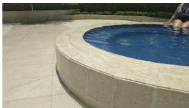
Reparación de manga de Jacuzzi.
