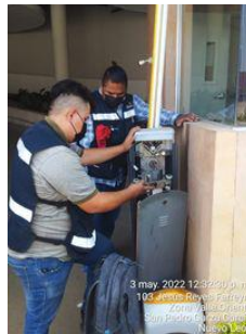
Reparación de control de salida en E1.
