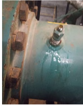
Se instala sensor de flujo en chiller #1.
