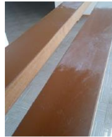
Limpieza de estructura perimetral de Salón Múltiple y Lobby Torre West.
