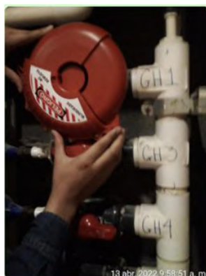
Se colocan nuevas seguridades a las válvulas grandes.
