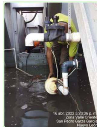
Se activa torre de enfriamiento N°1 se coloca y nivela el flotador
