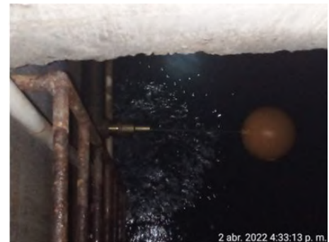
Se destapa sistema de toberas de las torres de enfriamiento
