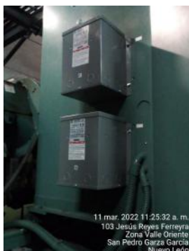
Instalación de transformadores para el diagnóstico del chiller #1 por falla
