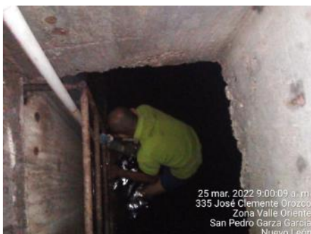
Colocación de válvula en la cisterna del jardín de caseta 1
