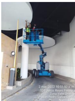
Cambio de iluminación de área de rampa
