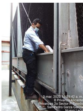
Seguimiento semanal a la calidad del agua en torres de enfriamiento
