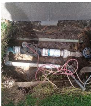
Revisión y cambio de válvula para riego en jardín
