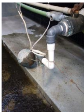
Fijación del flotador de torre #4 para su arranque
