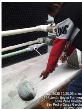
Nivelación de bacín de torre #1 para su arranque
