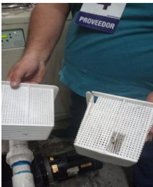
Cambio de canastillas de bombas de Jacuzzi
