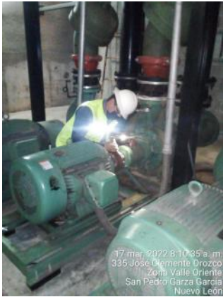
Reparación de Brida y sello mecánico de bombas secundarias de chillers
