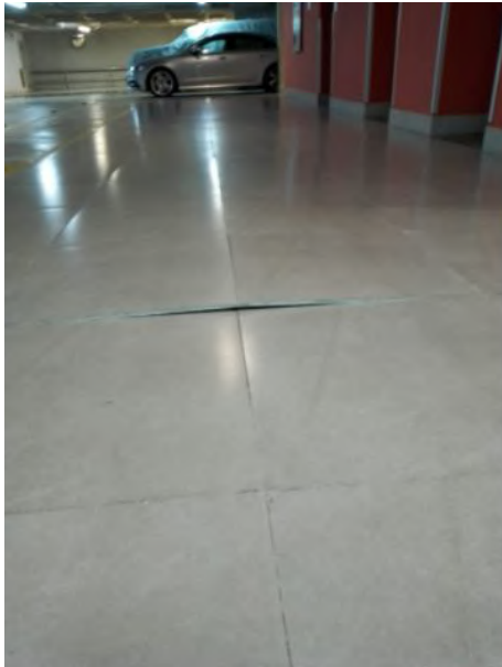
Se cambian pisos quebrados en E3 frente a elevadores.
