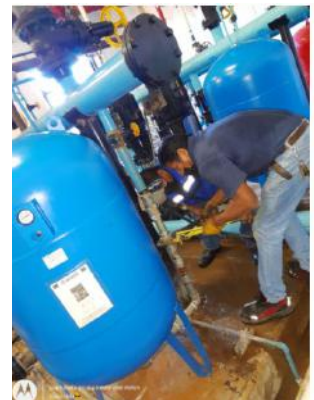
Mantenimiento al tanque de precargado de baja presión
