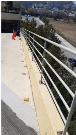
Pintura en barandal del motor lobby.
