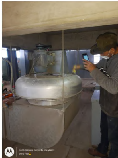
Mantenimiento a extractores de aire de torre East.
