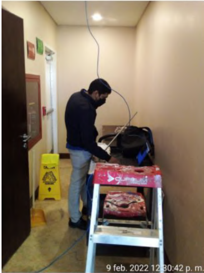
Reinstalación del servicio para el control de climas en áreas comunes.
