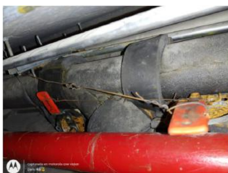
Reparación de fuga en piso 17.
