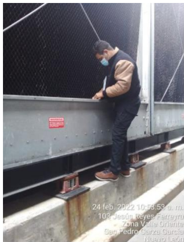
Seguimiento al control de la calidad del agua para chiller.
