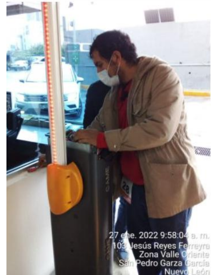
Personal de Neuroservices reprogramando barrera de acceso y salida de E5.
