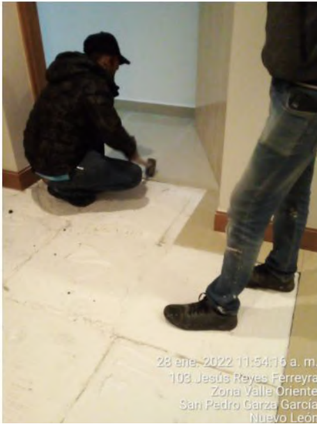
Personal de COREMA habilitando piso del nivel 9 frente al departamento 94.
