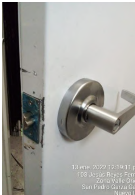
Reparación de chapa de Chapa de cubo eléctrico.
