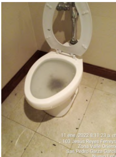
Reparación de sanitario en Torre West.
