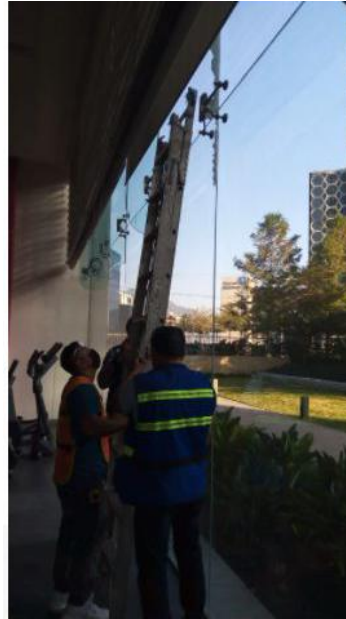
Personal de Aluvri apoyando a personal que instala costilla en Gym East
