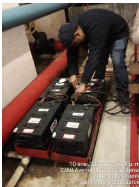
Revisión mensual de equipo contra incendio.
