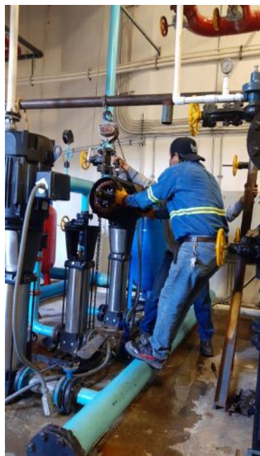
Reparación de motor de Hidroneumáticos
