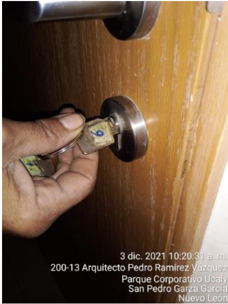
Cambio de chapa dañada en Zinc de limpieza
