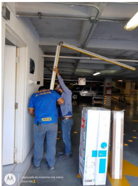
Instalación de la barrera de acceso en E5
