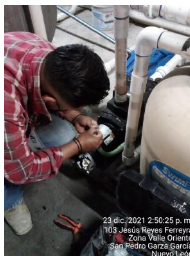
Reparación de bomba de chapoteadero
