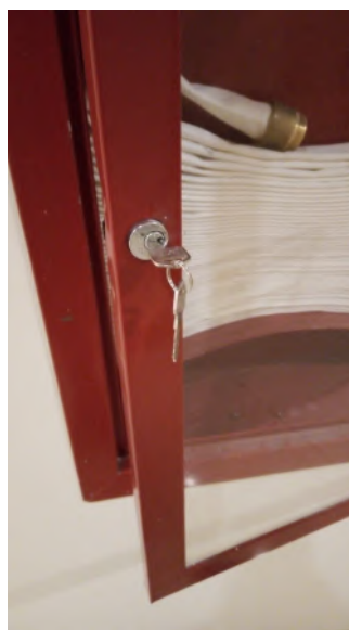
Instalación de chapas en cubos de extintores
