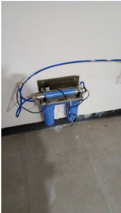
Mantenimiento al filtro de bebederos área de alberca
