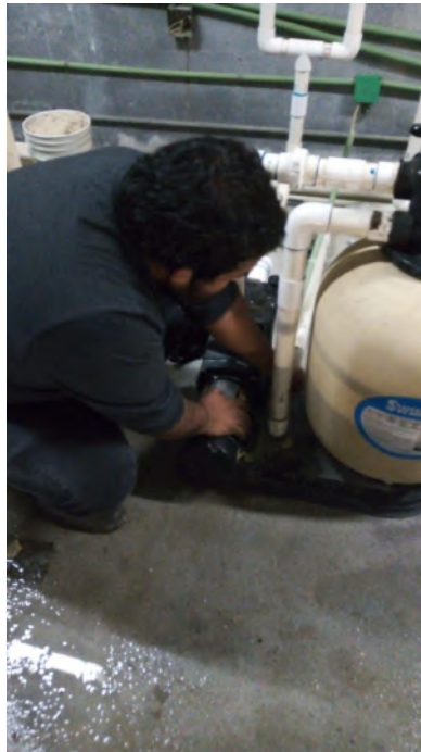
Reparación de bomba de chapoteadero
