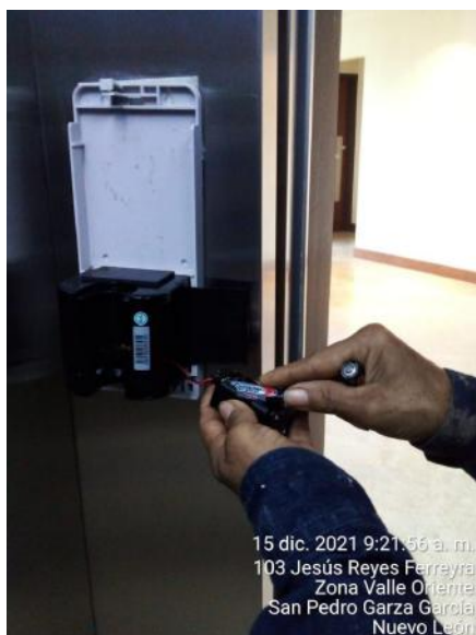
Reparación de dosificadores de Gel en elevadores
