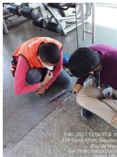
Reparación de acceso a GyM de torre East
