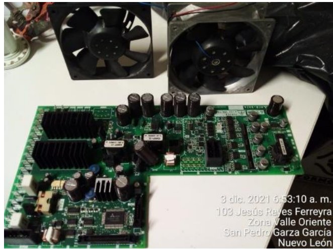
cambio de componentes dañados en elevador de torre west
