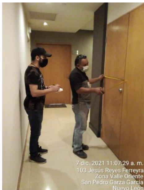
Revisión y adecuación de puertas en torre East, prueba.
