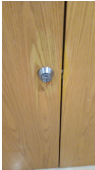
Cambio de chapas por seguridad de violación a servicio de agua por reduccion de de morosos.
