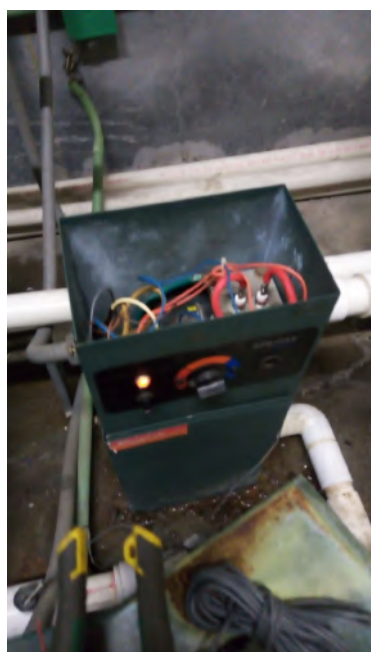
Cambio de la resistencia del Jacuzzi
