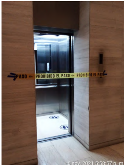
Mitsubishi diagnóstica falla de elevadores en Torre East.
