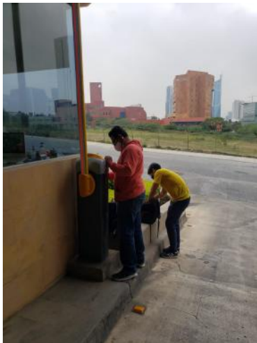
Reparación de barrera de salida de acceso principal sobre Jesús Reyes Ferreyra por falla mecánica.
