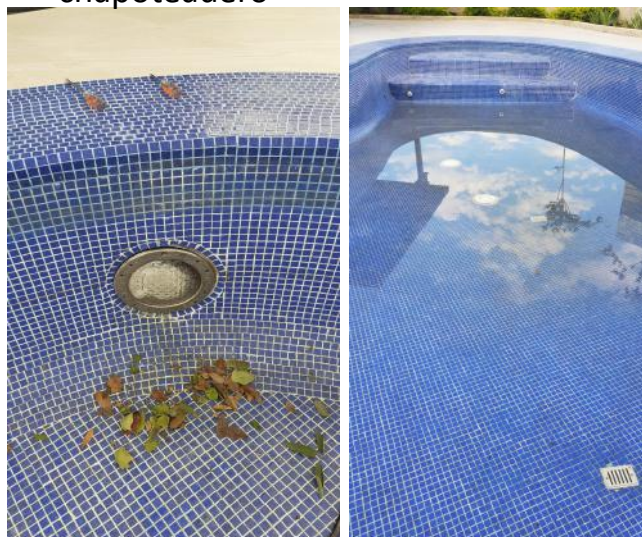
Instalación de foco y limpieza de chapoteadero
