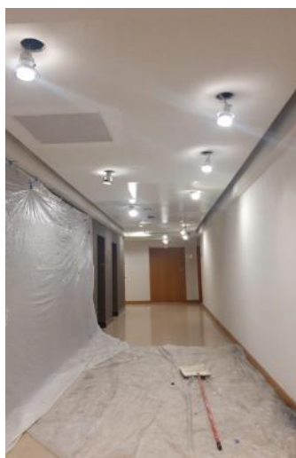
pintura de los plafones en torre West
