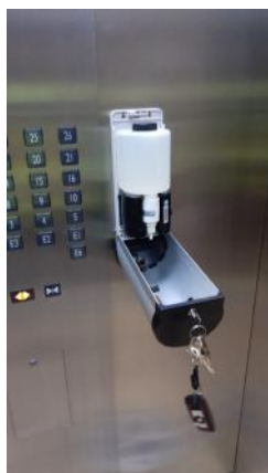
Limpieza, relleno, cambio de baterías de dosificadores.
