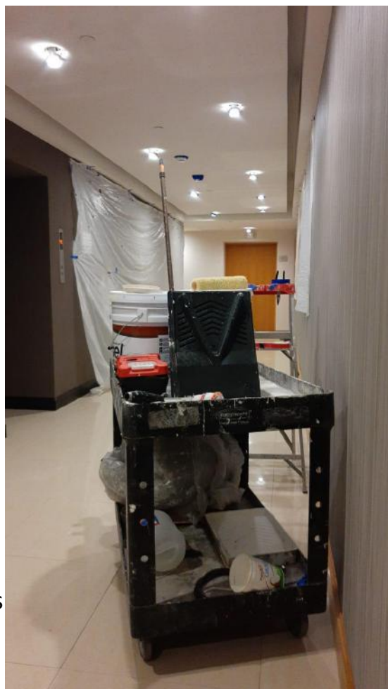
Pintura de plafones en torre West
