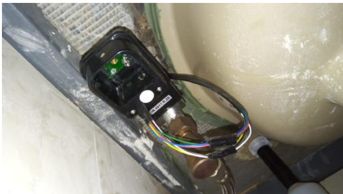
Mantenimiento correctivo a sensores de lavabos
