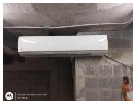
Limpieza y mantenimiento de climas
