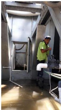
colocación de flotador para el nivel de agua en torres de enfriamiento
