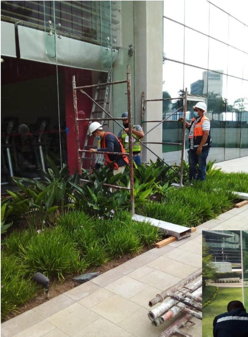
Trabajos de alineación, ajuste y reemplazo de herrajes desgastados o no existentes en fachada de cristal de gimnasio Torre East.
