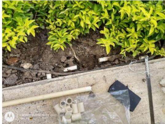
Reparación del sistema de riego por fuga
