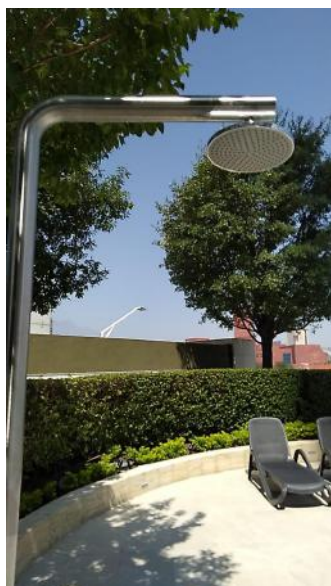
Suministro y colocacion de regadera en area de alberca.
