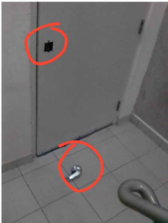
Colocación de visagras y chapas que presentaban falla en ambas Torres.
