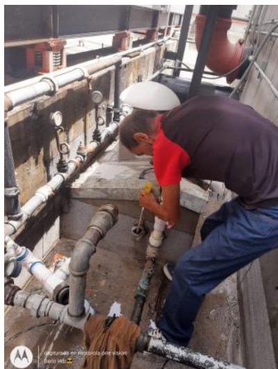
Cambio de válvula de torre de enfriamiento, por falla.
