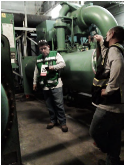
Reparación de Chiller 3 por falla en sensor de flujo, colocación de glicol en chiller 3.
