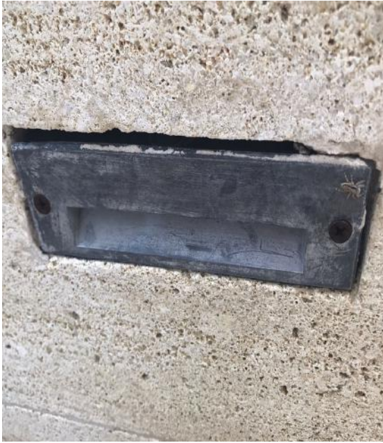
Suministro y colocacion de lagartijeras LED en tdo el perimetro area de alberca
