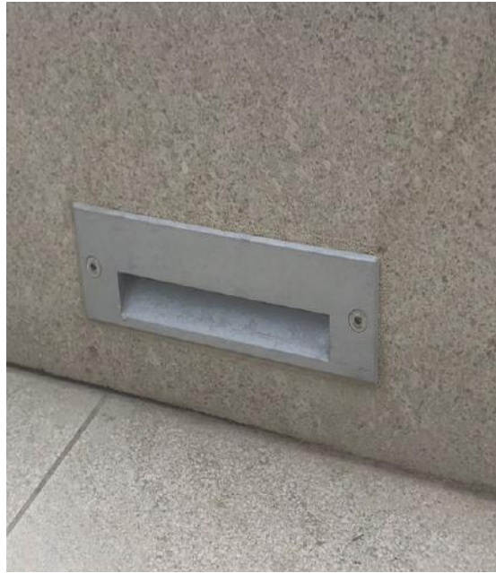
Suministro y colocacion de lagartijeras LED en tdo el perimetro area de alberca
