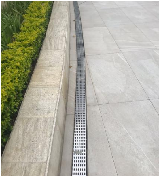
Suministro y colocacion de coladera fabricada a la medida en acero inoxidable en zona de alberca.
