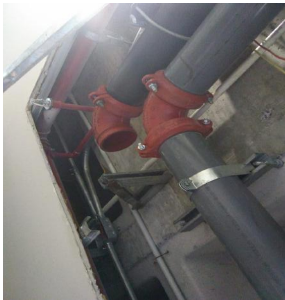
Fuga presentada en tubería de alta presión reparada por Ingeniería Hidroneumática en E2.
