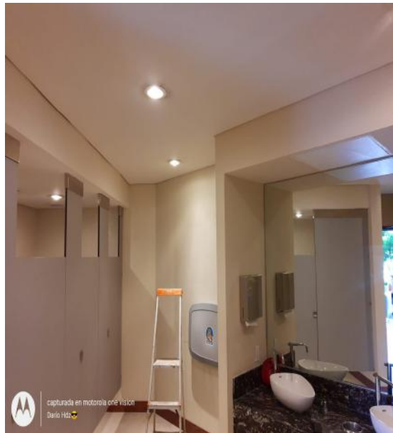
Se cambia iluminación de luz blanca a cálida y led en baños de visitas de ambas torres y area de alberca.
