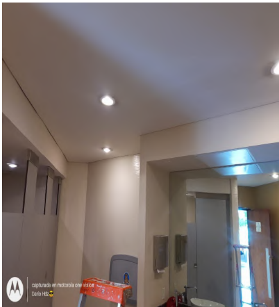
Se cambia iluminación de luz blanca a cálida y led en baños de visitas de ambas torres y area de alberca.
