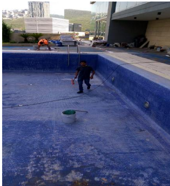
Se continua con emboquillado en casco de alberca y colocación de veneciano faltante
