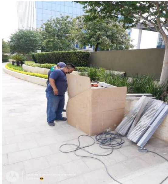
Suministro y colocacion de coladera fabricada a la medida en acero inoxidable en zona de alberca.
