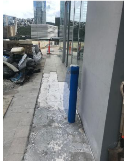
Recolocación de pisos dañados en banqueta perimetral
