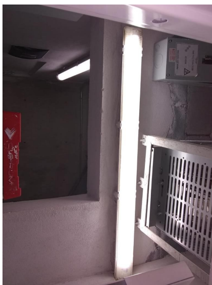
Se realiza el cambio de luminarias fundidas en área de estacionamiento.
