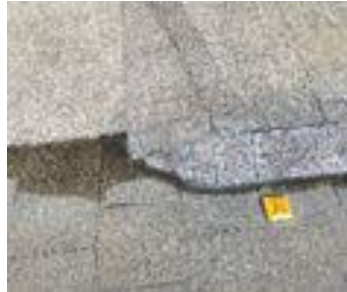
Reparacion de piso terrazo en entrada a Lobby West.
