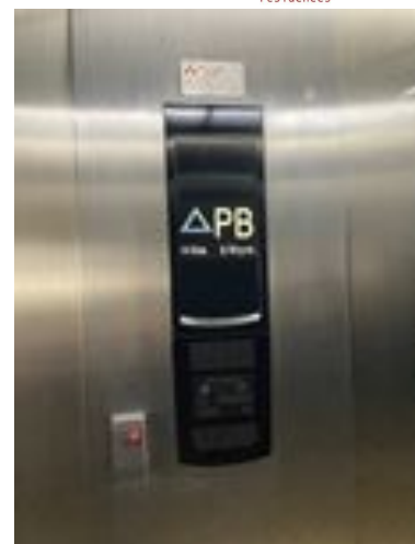
Suministro e instalación de display en pantalla de cabina de elevador de carga en torre West.
