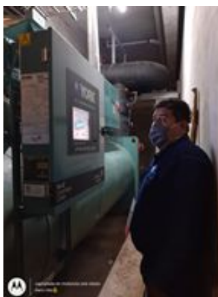
Mantenimiento de chillers en sótano E2.
