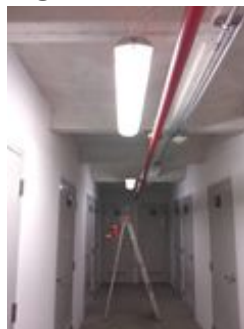
Reparación y cambio de focos LED en lámparas de emergencia ubicadas en el cubo de escaleras de ambas torres en estacionamientos y bodegas de E-6.
