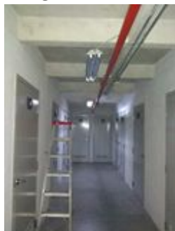
Reparación y cambio de focos LED en lámparas de emergencia ubicadas en el cubo de escaleras de ambas torres en estacionamientos y bodegas de E-6.
