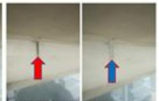
Se aplica sello en toda la parte superior y detalle de unión de perfiles de aluminio
