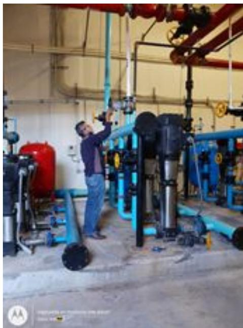
Reparación de sello de bomba de equipo de alta presión por Ingeniería Hidroneumatica en cuarto hidroneumático en Sotano 1.
