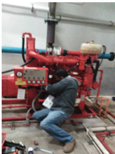
Cambio de filtro de presión de aceite de equipo contra incendio, por parte de Ingeniería Hidroneumatica.
