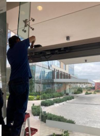
Mantenimiento, limpieza de cabezal, instalacion de guias, instalación de regulador de voltaje para el correcto funcionamiento de puerta automática de torre east.
