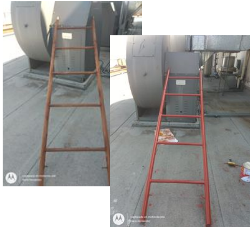
Aplicación de mano de pintura al andamio que se usa como escalera en azotea de Torre East.
